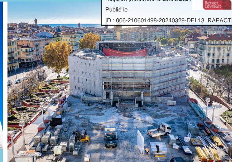
* Travaux de déconstruction du bâtiment qui abritait le TNN
