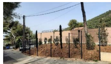
* Extension du réservoir Saint-Michel à Villefranche-sur-Mer (réception de l'ouvrage)
