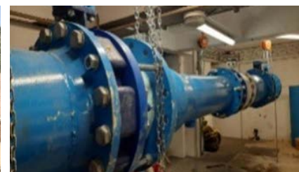
* Réhabilitation de la station de pompage de la Moyenne Corniche à Nice Col de Villefranche
