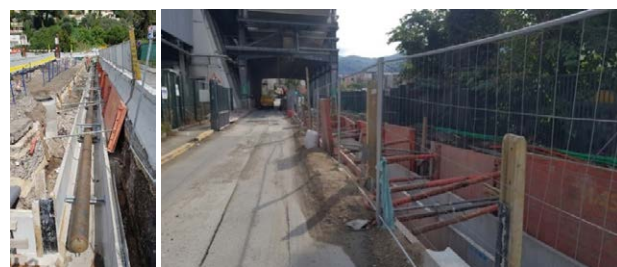
* Dévoisement des réseaux vapeur et eau chaude alimentant le quartier de l'Ariane en préparation des travaux de modernisation de l'UVE Arianeo
