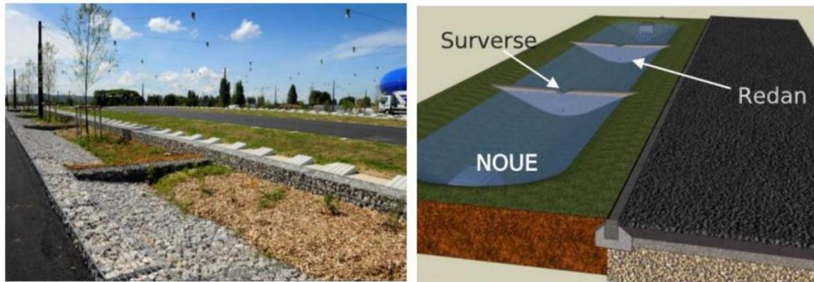
Figure 23 : exemple de noues à redans (source photo : infra SERVICES)
