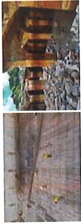
Démolition voûte et poteaux
