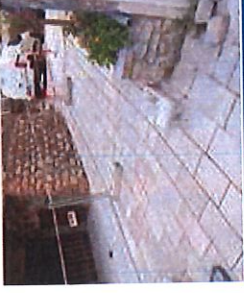
SAINT-DALMAS-LE-SÉVIGNE : Aménagement de la place centrale
