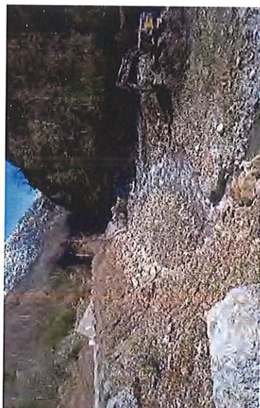
CARROS / LE BROCC : Curage du canal pied de colaux suite aux intempéries du 23 octobre 2024 (afflux de sédiments et de bois morts en provenance du vallon du Riou).
